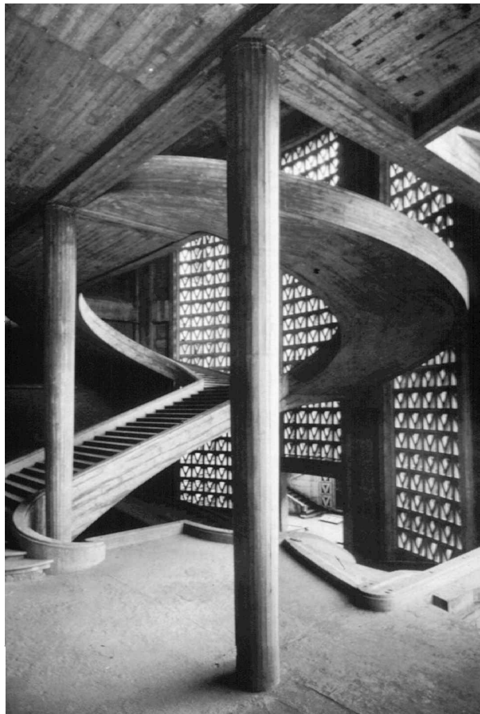
1. Staircase under construction, Musée des Travaux Publics, 1937. Courtesy of Institut français d'architecture.
